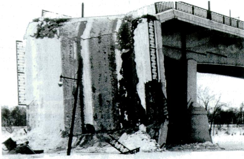
Ruptura de uma ponte metálica no Canadá, acontecida em 1951. A estrutura rompeu de forma frágil numa noite de inverno ( $-30^{\circ}\text{C}$ ), num momento em que a ponte não estava sequer submetida a uma grande solicitação.
